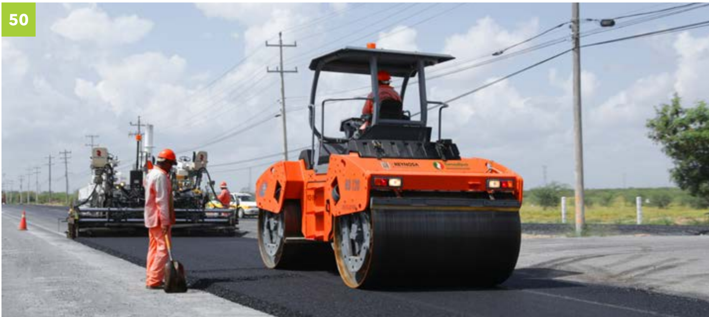
49. Obras de revestimiento en el canal Rodhe supera los 59 millones de pesos. 50. En atención a infraestructura y equipamiento urbano se construyeron 50 nuevas vialidades.
